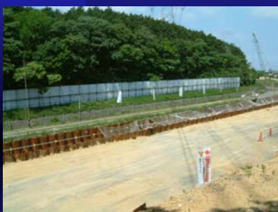
縁切用仮設塀の設置
