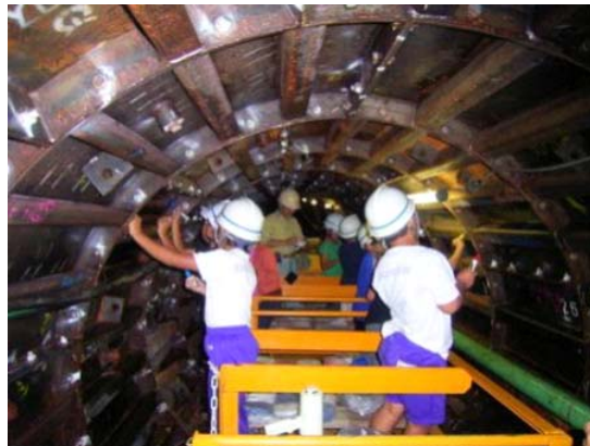
工事現場見学会の様子
