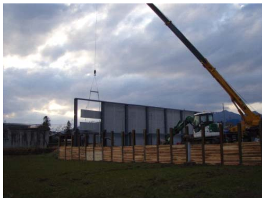
防音壁の設置
