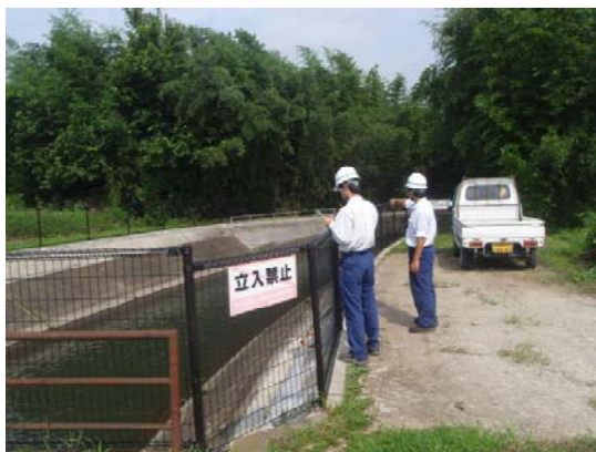
施設の巡視状況
