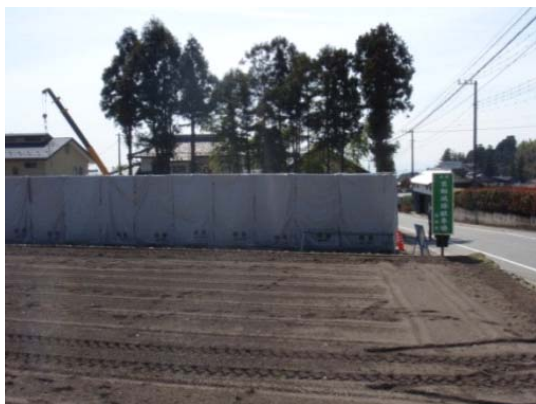
防音シートの設置
