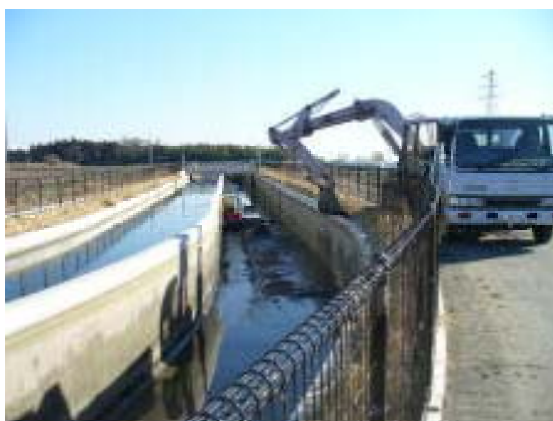
開水路の土砂撤去状況
