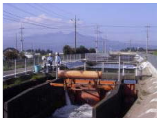
ゲート設備の点検
