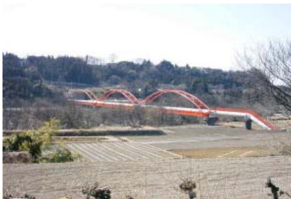
施工箇所（利根川サイホン）
