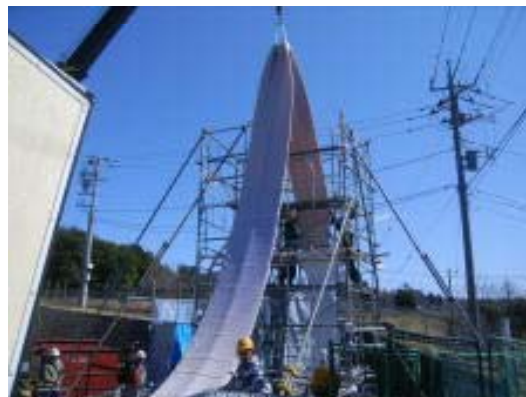
改築中の支線水路（反転工法）
