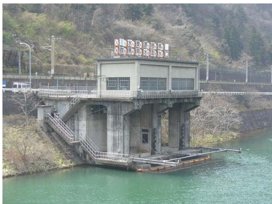
取水口上屋改築（施工前）
