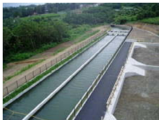
改築後の開水路
