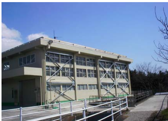
改築後の西部揚水機場（鉄骨ﾌﾟﾚｽ補強）
