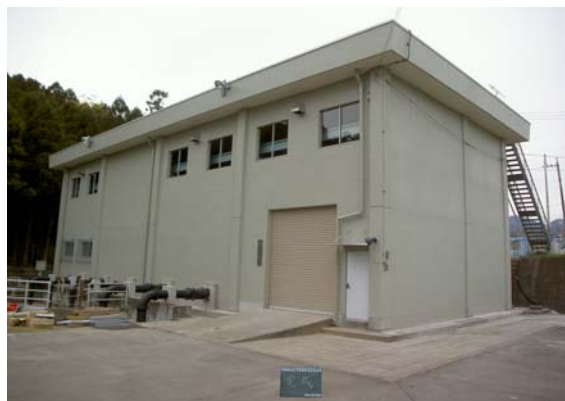
改築後の相馬揚水機場（ＲＣ補強壁）
