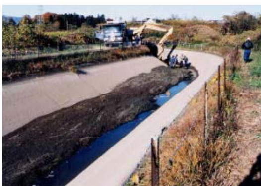
改築前の開水路（土砂撤去状況）
