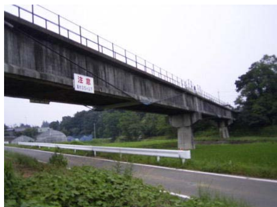
改築後の水管橋（たわみ防止）
