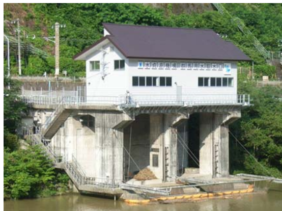
取水口上屋改築（施工後）
