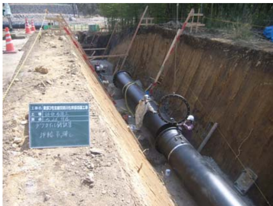
改築中の支線水路（ダクタイル鋳鉄管布設）
