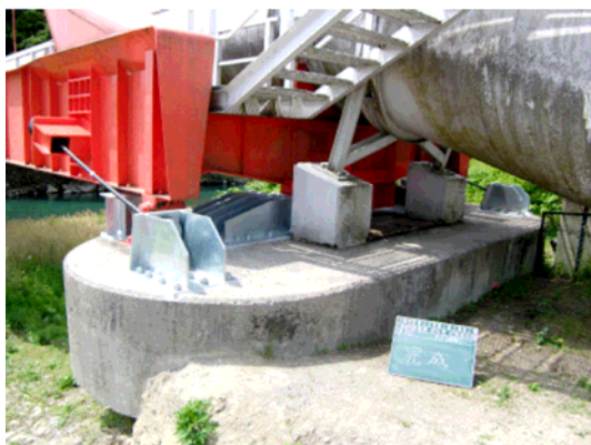
改築後の水管橋（落橋防止）
