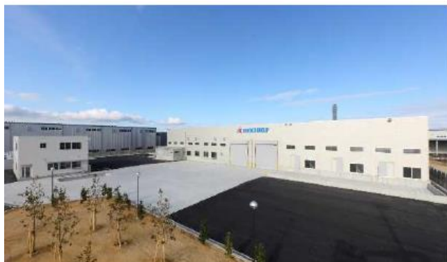
水処理分析機器を保有する岸之浦工場
