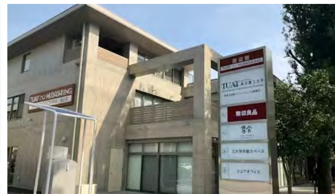
東京農工大学 邂逅館 東京都府中市幸町 3-5-8
