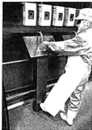
図 2 2 足踏み式手洗い洗浄装置
