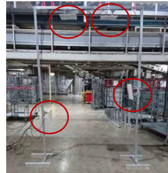
＜ゲートタイプのアンテナ配置＞
