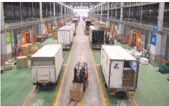
荷卸し待機時間の少ない入荷施設
