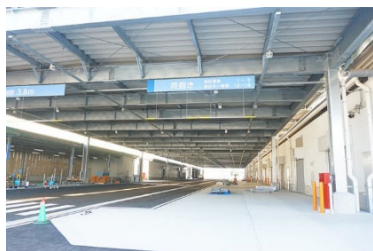
大屋根下の荷卸し場
