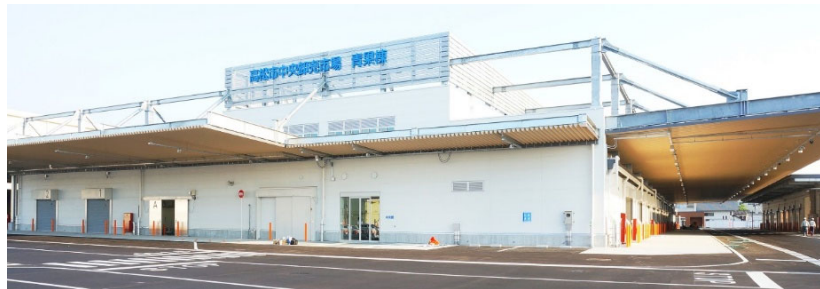
コンパクトな閉鎖型施設
