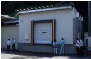
清水市中央卸売市場のドックシェルター付き冷蔵倉庫
