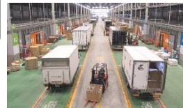
効率的な荷下ろしが可能な施設構造
