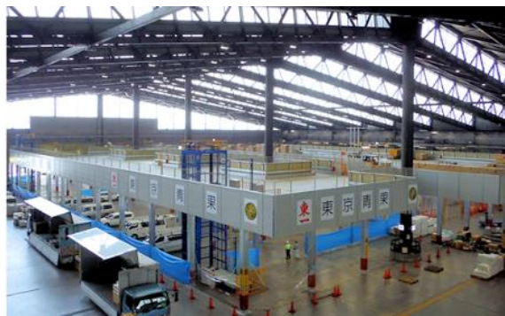
1階は空調機とカーテン設置で定温保管可能 2階へは垂直搬送機で荷を移動
