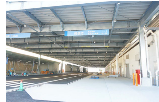
大屋根下の荷卸し場
