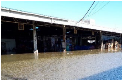
大雨による浸水被害（荷捌場）
