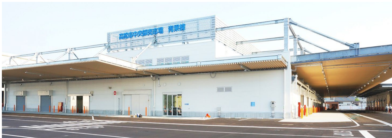
コンパクトな閉鎖型施設
