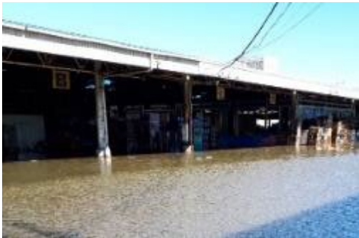
大雨による浸水被害（荷捌場）
