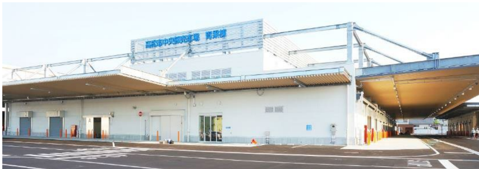
コンパクトな閉鎖型施設
