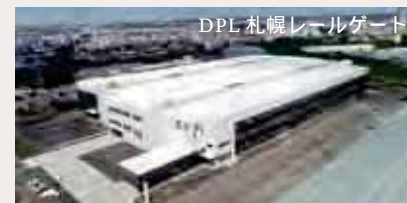
DPL 札幌レールゲート
