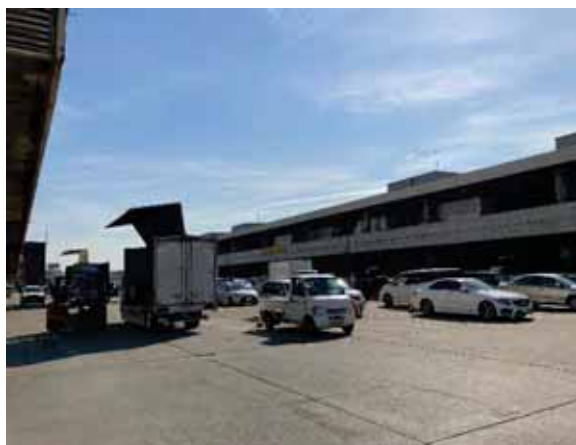
市場施設内（2F）荷受け場① セリ後の出荷も落ち着き、閑散としていた。
