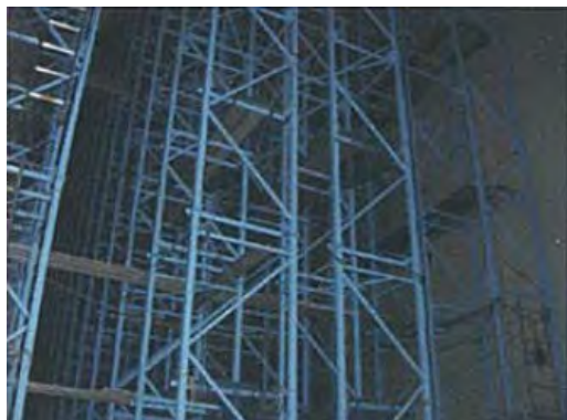
(自動倉庫設備)
