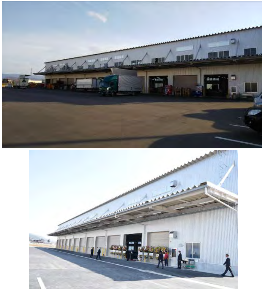
図表 3-6 広域集出荷施設
