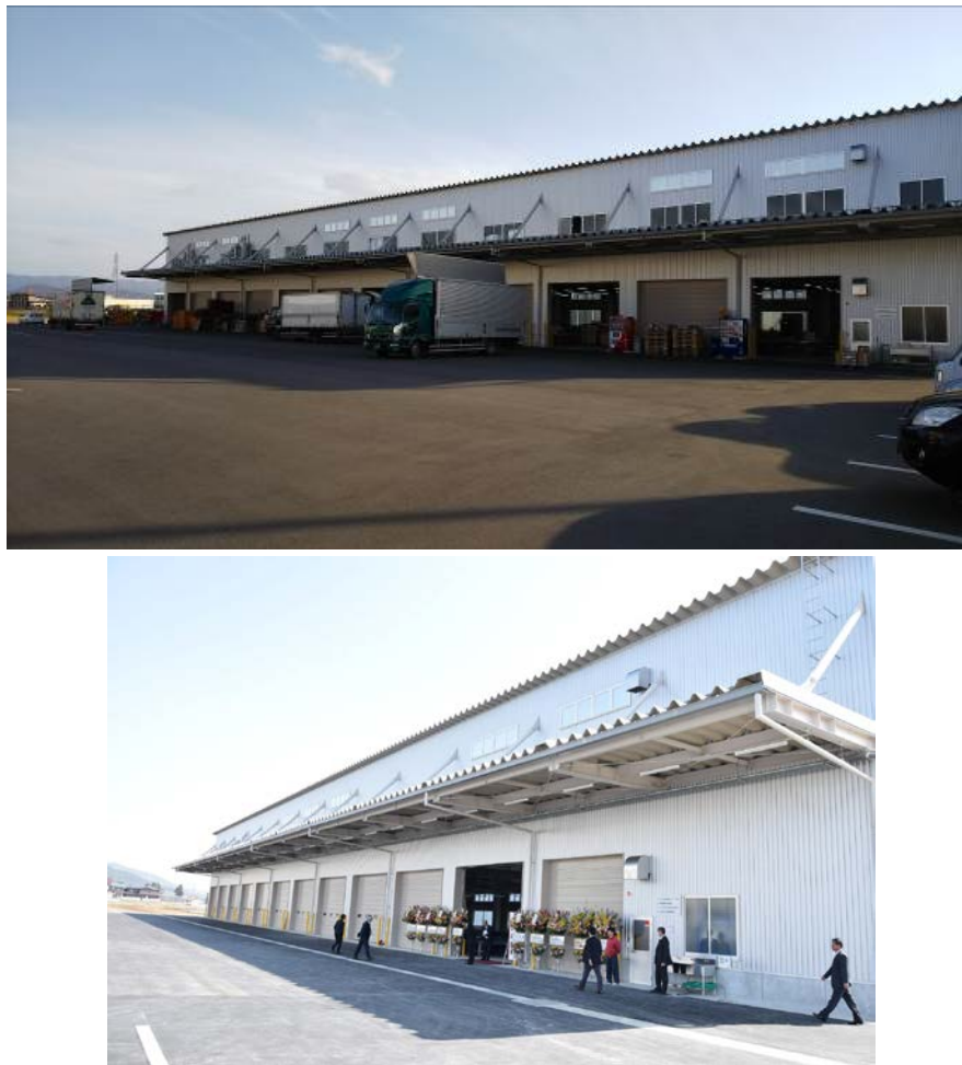
図表 3-6 広域集出荷施設
