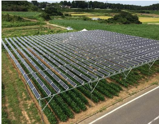
発電施設の外観
