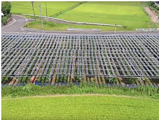
発電施設の外観
