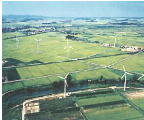
水田地帯に設置された風車
