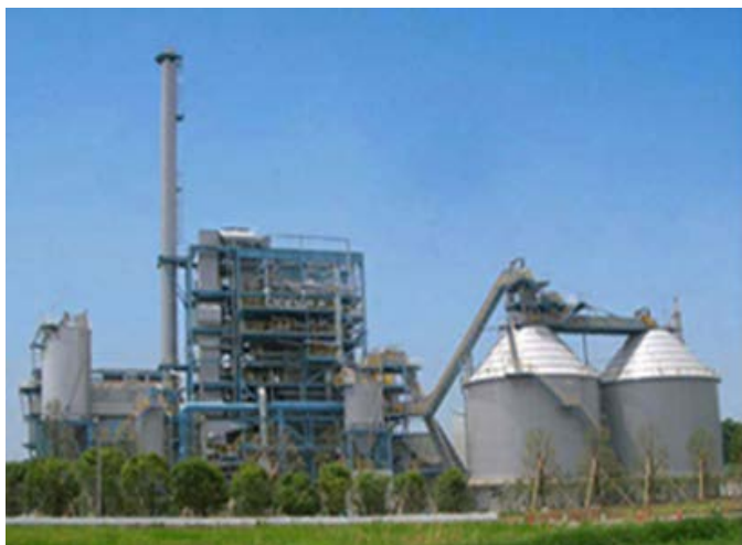
発電施設の外観
