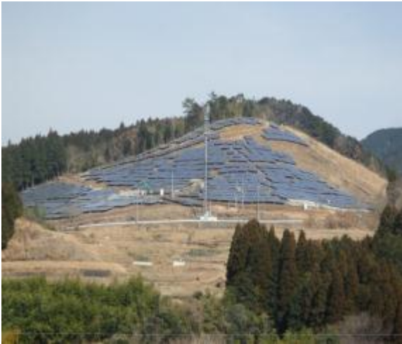
発電施設の全景
