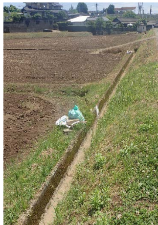
補修された水路
