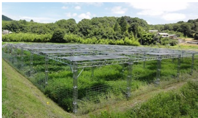
宝塚すみれ発電4号機 全景
