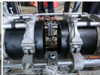
② 導水管路 〔高密度ポリエチレン管 バット融着状況〕
