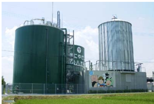
バイオガス発電施設の外観
