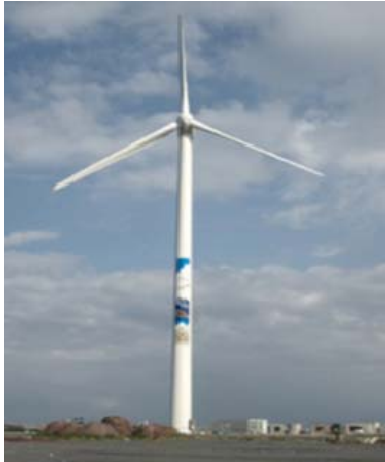
漁港内に設置された風車
