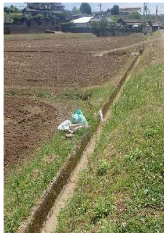
補修された水路
