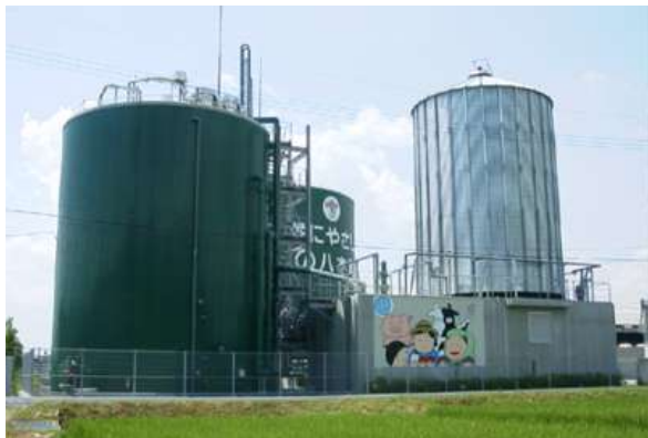
バイオガス発電施設の外観
