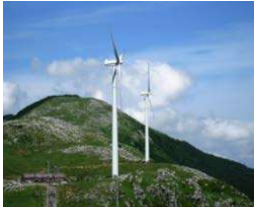
高原に設置された風車
