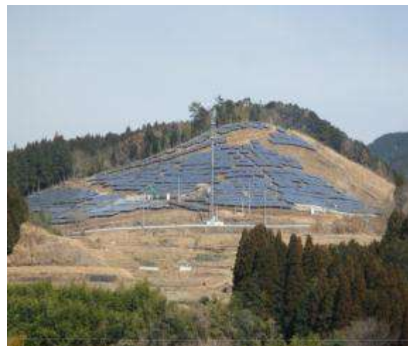
発電施設の全景
