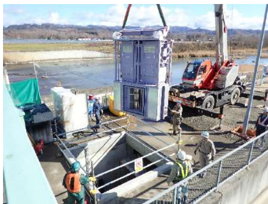
水車設置作業の様子
