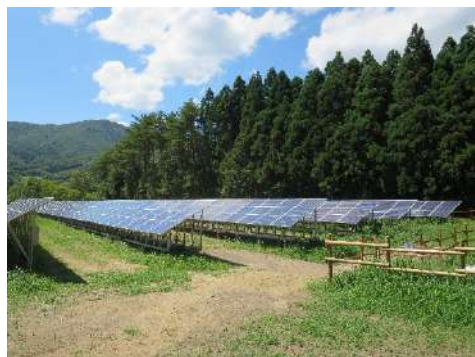
発電施設の外観(郡山)
