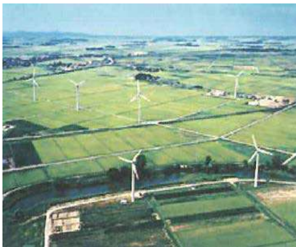
水田地帯に設置された風車
