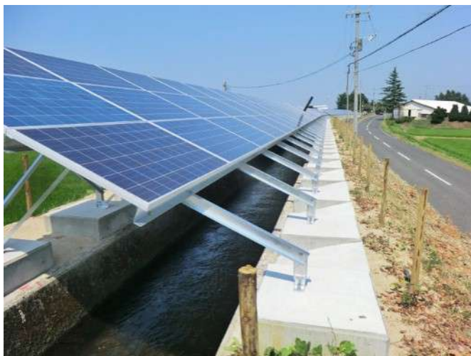
かんがい用水路の上部の発電施設
