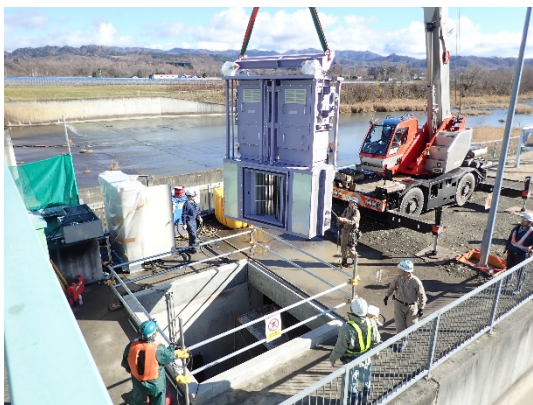
水車設置作業の様子
