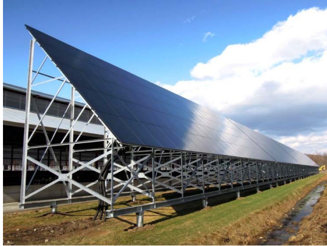
発電施設の外観
