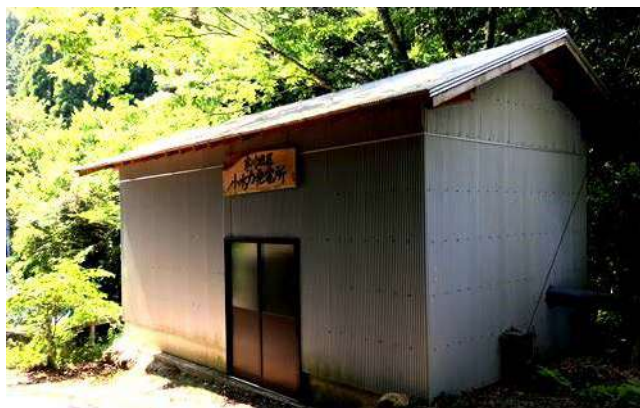
発電施設の外観
