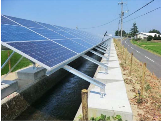
かんがい用水路の上部の発電施設
