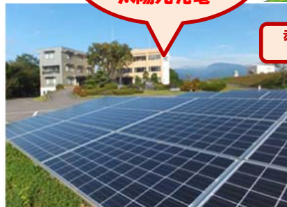
赤田太陽光発電所 太陽光パネル：1,680枚 最大出力：400kW
