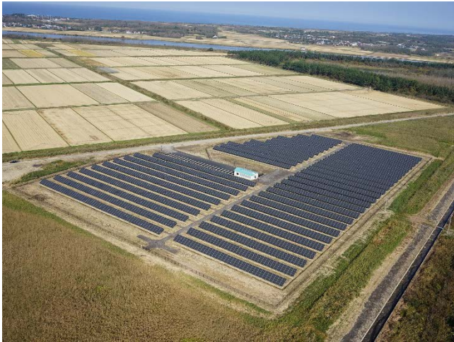
発電施設の外観
