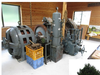
展示室内の旧発 電所の水車等
