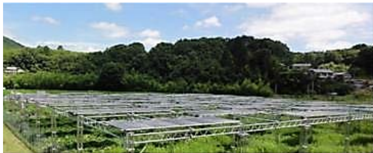
発電施設の外観
