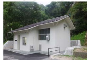
町営仁多発電所
