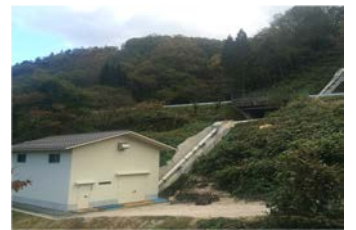
町営阿井発電所
