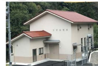
町営三沢発電所
