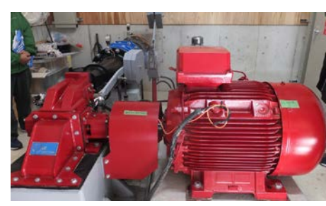
水車と発電機
