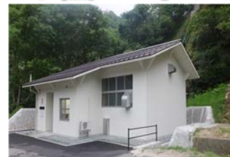
町営仁多発電所
