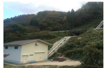
町営阿井発電所
