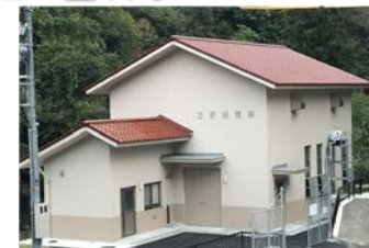
町営三沢発電所
