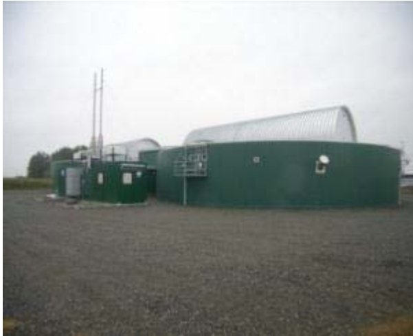
バイオガス発電施設の外観
