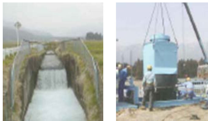
百村発電所 水車設置前の水路と設置工事の様子
