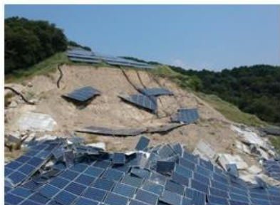
土砂崩れで生じた崩落
