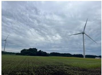
白神ウインドパワー発電所の外観
