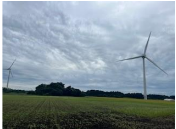
白神ウインドパワー発電所の外観
