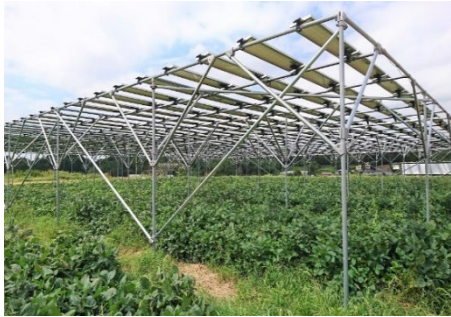
発電設備の外観
