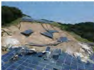
土砂崩れで生じた崩落
