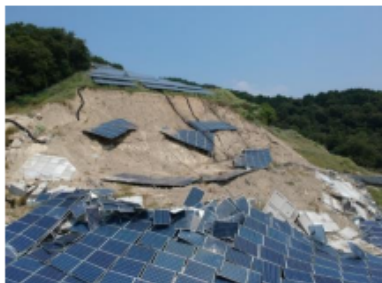
土砂崩れで生じた崩落
