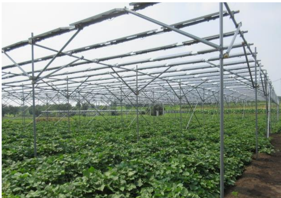
露地の畑の上部にパネルを設置
