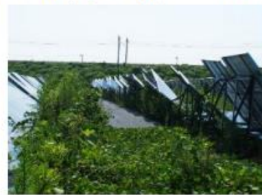
不十分な管理で放置されたパネル
