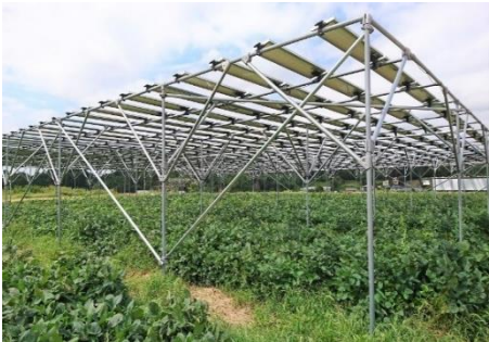
発電設備の外観
